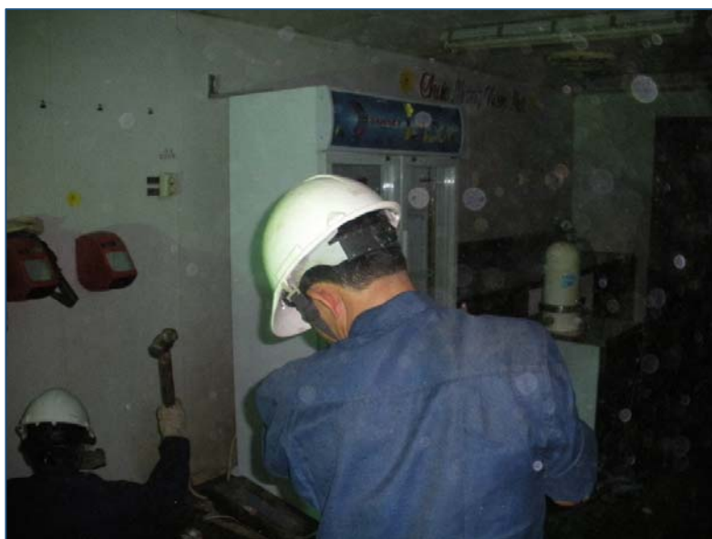
Các Công nhân PVSb đang thi công sửa chữa Giàn Tam Đảo 01
