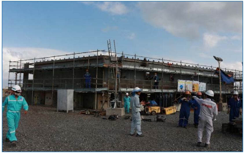
Hoạt động thi công, lắp đặt Block nhà ở giàn khoan Tam Đảo
