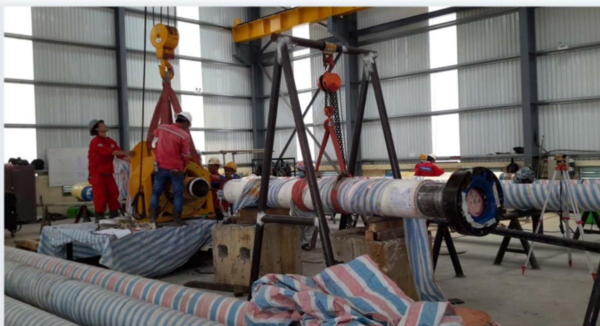
Chế tạo Riser Spool cho dự án SubSea7
