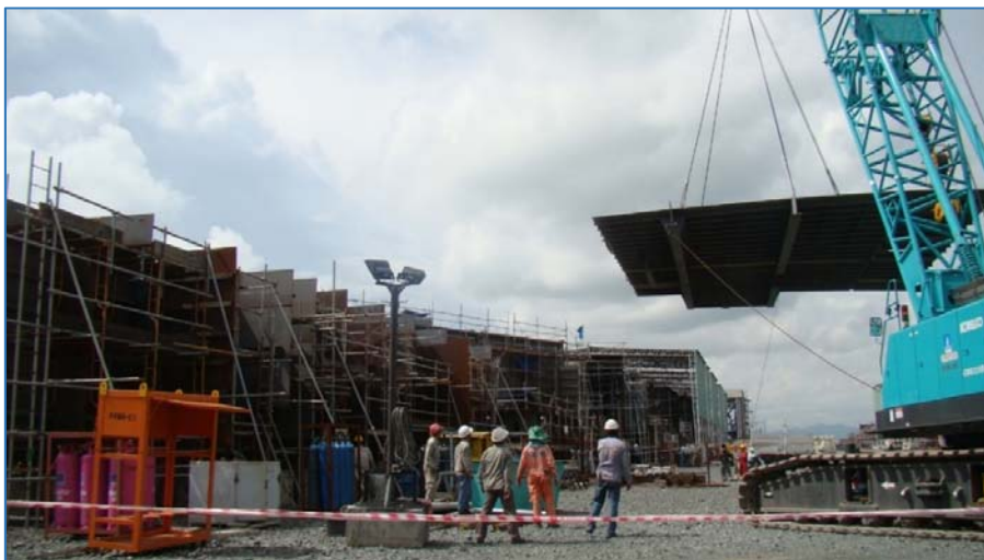
Công nhân PVSBS làm việc tại công trường - thi công các khối block số 16 cho giàn khoan dầu khí tự nâng 90m nước
